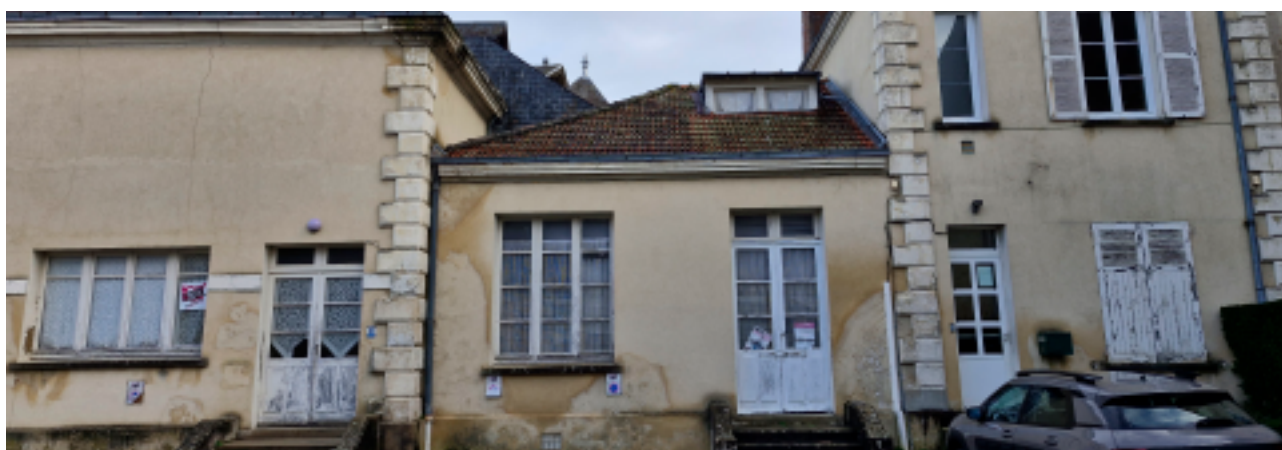
A droite, locaux communaux d'hébergement d'urgence abandonnés
