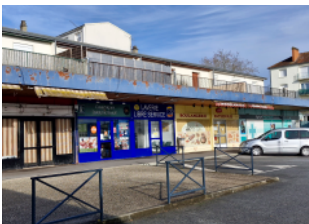
Centre commercial des Gauchetières
